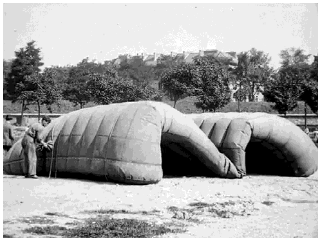
Gonflage de l'enveloppe avec un générateur d'air
