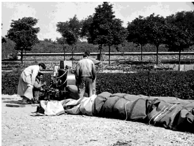
Gonflage de l'enveloppe avec un générateur d'air
