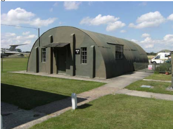
Exemple visible sur la base d'Elvington (Angleterre) (Coll. Laurent Bailleul)
