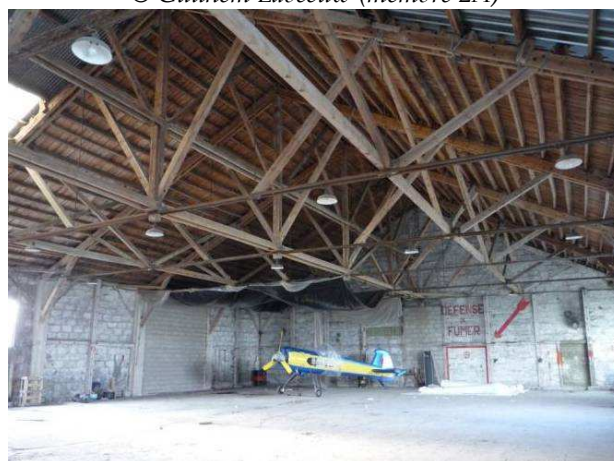
Vue de l'intérieur. Remarquer l'état de la charpente.
