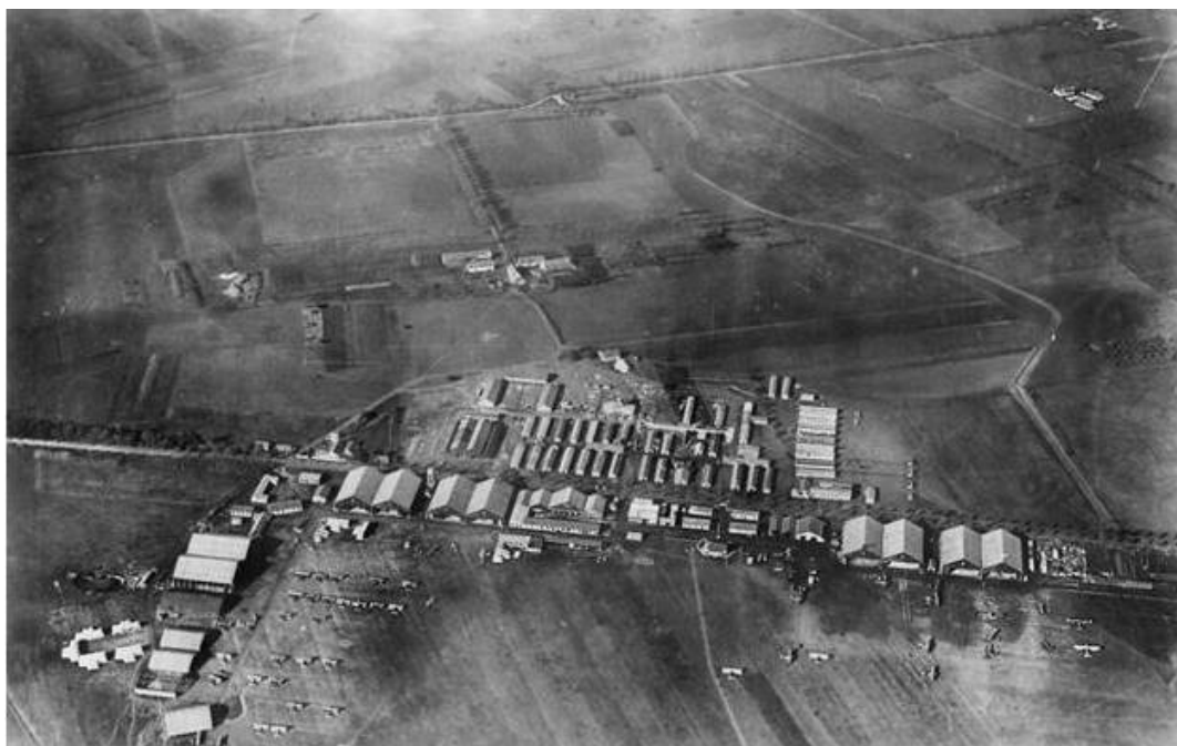
Vue aérienne des installations en septembre 1918 (National Archives de Washington)
