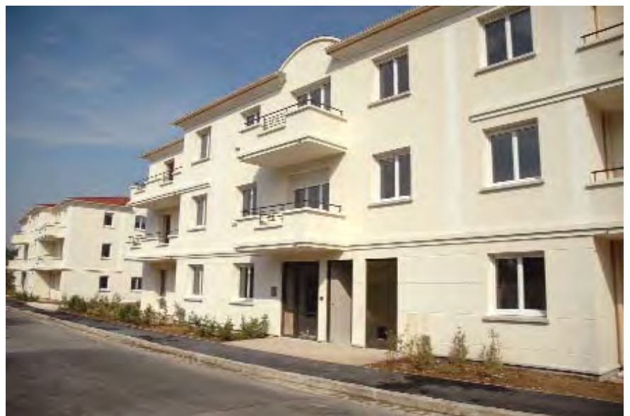
Appartements de la nouvelle résidence de la Roseraie à Brétigny sur Orge
